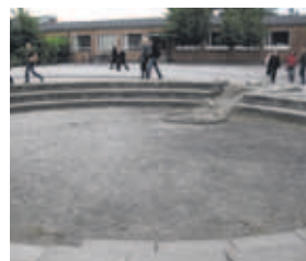
Et amfiteater i en skolegård fungerer samtidig som regnvandsbassin i tilfælde af kraftig regn. Foto: Marina Bergen Jensen
